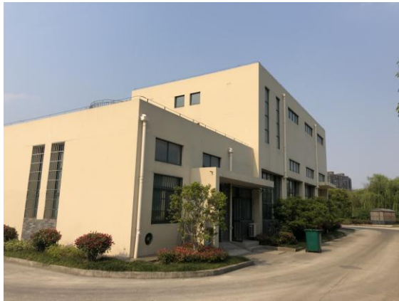
石白漾水厂污泥处理值班室
