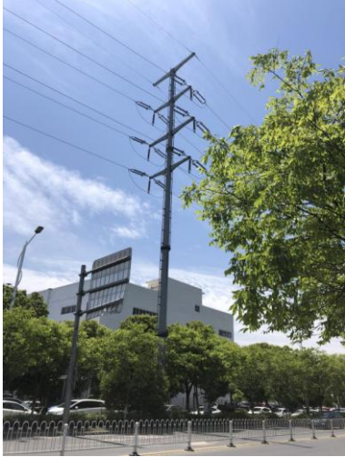
雨凌 1395 线 9 号塔下
